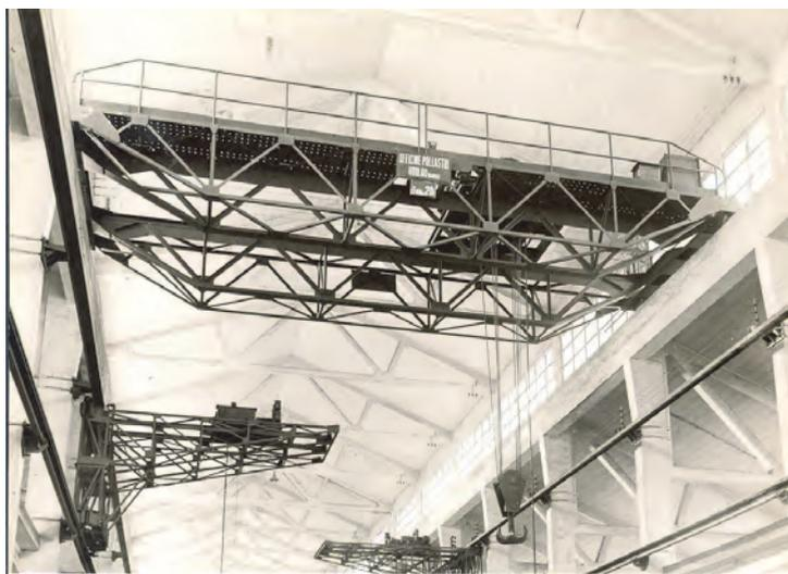
**Figura 2.** Ponte a traliccio, portata 20 t, luce 12 m. Costruzione anni '50. Per la cortesia dell'ing. Riccardo Pollastri.
